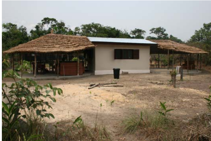
Nouvelle cuisine destinée à accueillir les touristes
